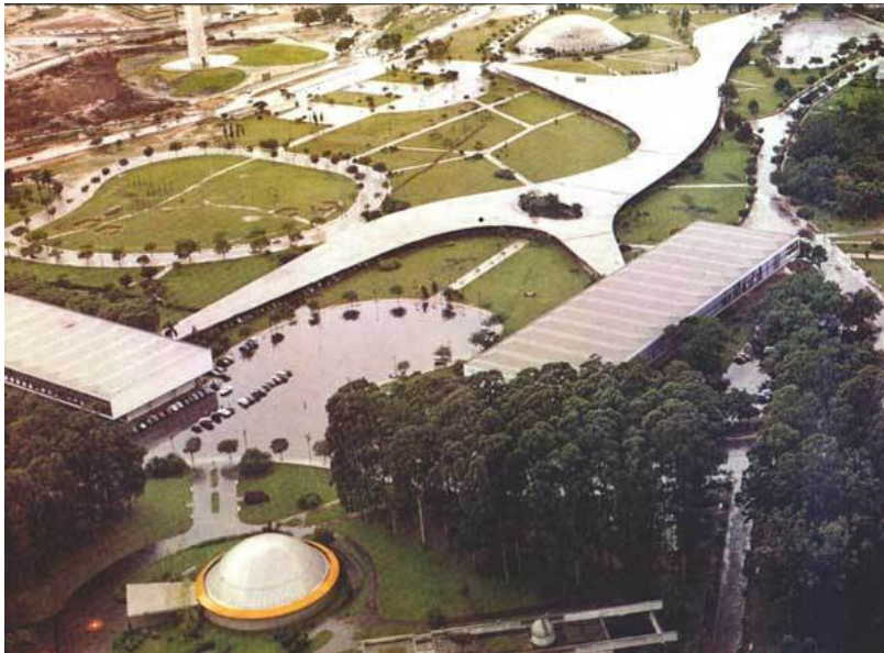
Figura 2 – Vista aérea parcial do Parque do Ibirapuera: marquise e imediações. Fonte: TÊAGÁ (2007).
